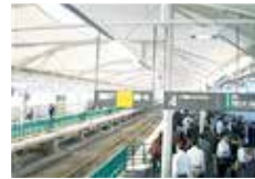
駅などのテント屋根
