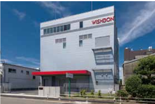
企業立地促進融資を利用し建設した新工場外観
