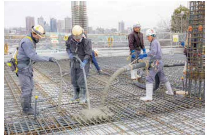
生コンクリートが一定時間すると固まってしまうため チームでムラなく手際良く流し込んでいきます
