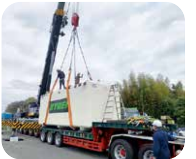
総重量30トンを超えるコンボルトタンクを200トンクレーンにてつり上げ設置します！
