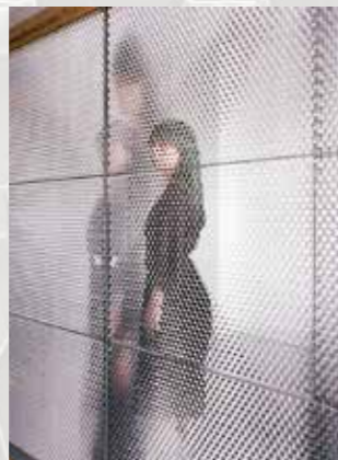
45度ハニカムを間仕切りに使えば、正面からの視線を遮りながら、光を取り込むことができる (撮影：八代写真事務所)
