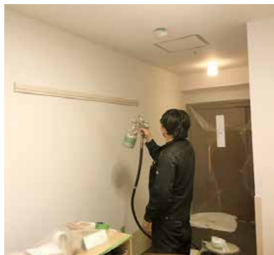
壁クロスへの施工
