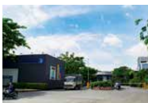
KIZUNA Readyサービス工場
