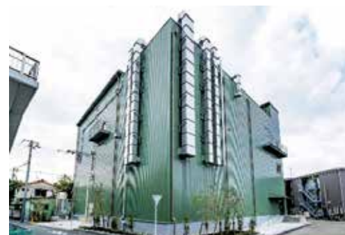
企業立地促進融資を利用し建設した新社屋外観
