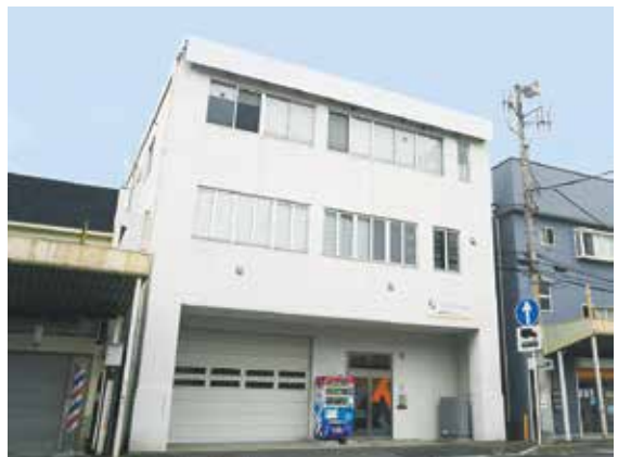
新事業所（横浜OFFICE）外観
