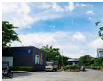
KIZUNA Readyサービス工場 (南部ロンアン省)
