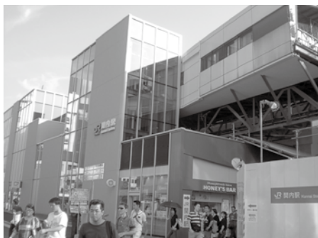
バリアフリー化工事などが完了したJR関内駅
