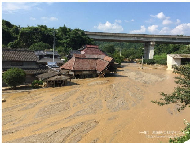
土砂災害現場
