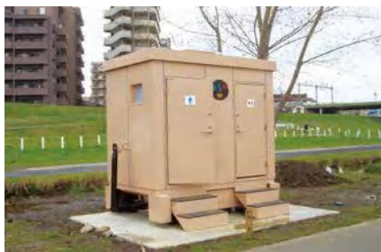
多摩川河川敷にあるトイレ本体すべてステンレス (塗装)
