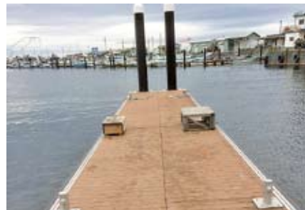
金沢漁港の浮桟橋
