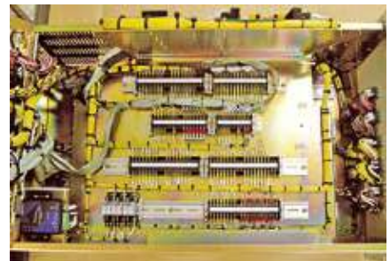
盤やユニットの組立配線
