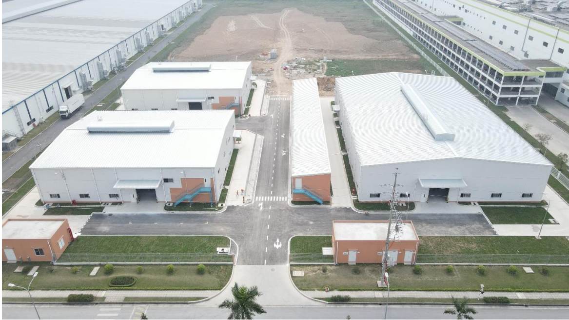
第三タンロン工業団地の貸工場区画（一部）外観
