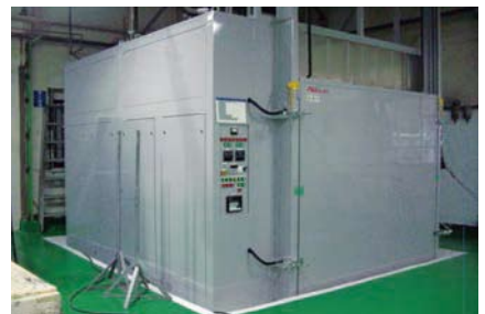
新設バッチ式大型ガス炉
