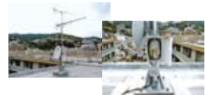
「ラグゼシア熱海静漣閣BS設備導入工事」より
