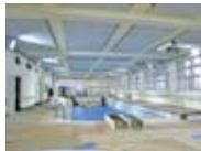
専門学校プール照明設備工事より
